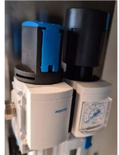
Afsluitklep perslucht in gesloten stand
