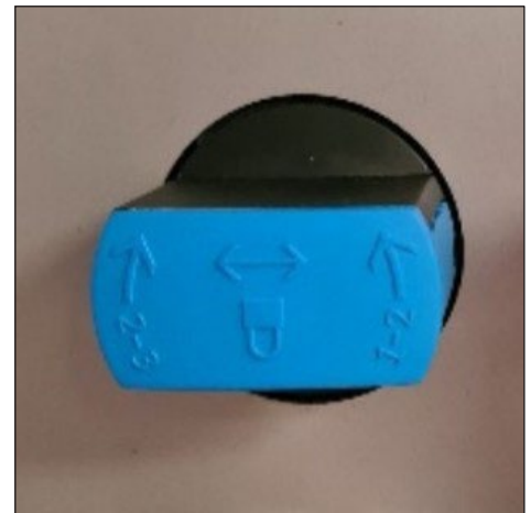
Persluchtventiel in geopende stand
