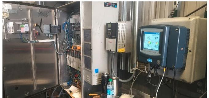
Figura 1: Control en tiempo real del espesamiento de fangos residuales (RTC-ST) de Hach instalado para ayudar a supervisar y adaptar el tratamiento químico, el nivel de pH y el caudal en la planta de tratamiento de aguas residuales de una fábrica de productos lácteos.
