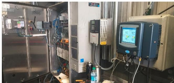
Figura 1: controllo in tempo reale dell'ispessimento dei fanghi (RTC-ST) di Hach installato per aiutare a monitorare e regolare il trattamento chimico, il livello di pH e il flusso nell'impianto di trattamento delle acque reflue di un impianto lattiero-caseario.
