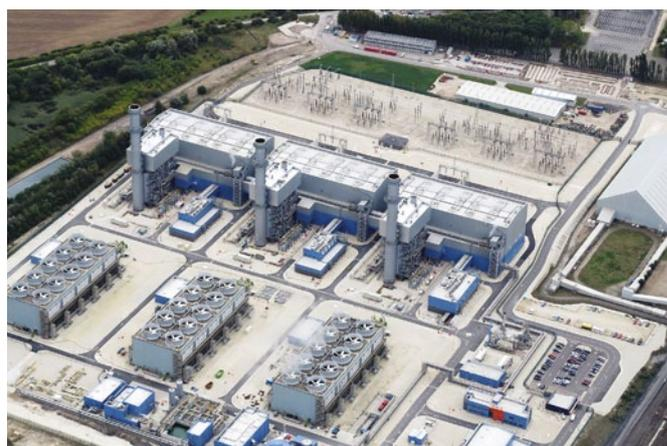
Centrale avec turbine à gaz à cycle combiné - site de West Burton B
