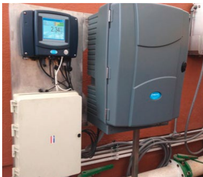
Rysunek 2: Przykład konfiguracji urządzeń współpracujących z modułem RTC-P
