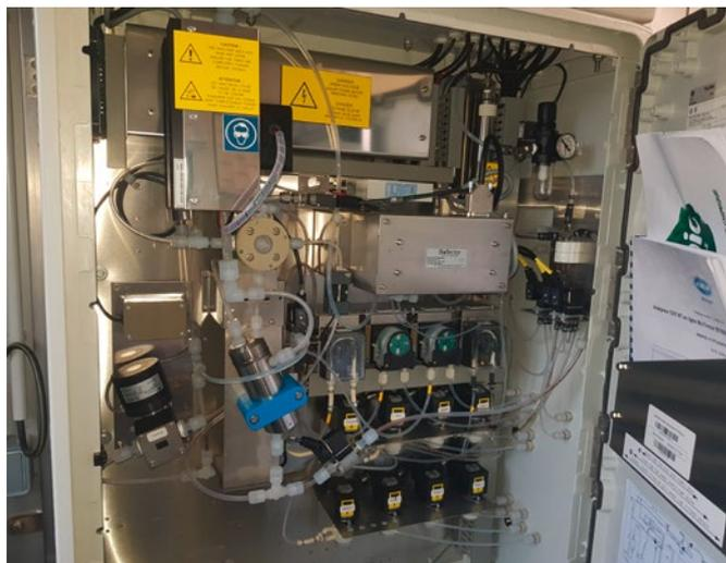
6-канальный анализатор ООУ/Общего азота Biotector B7000
