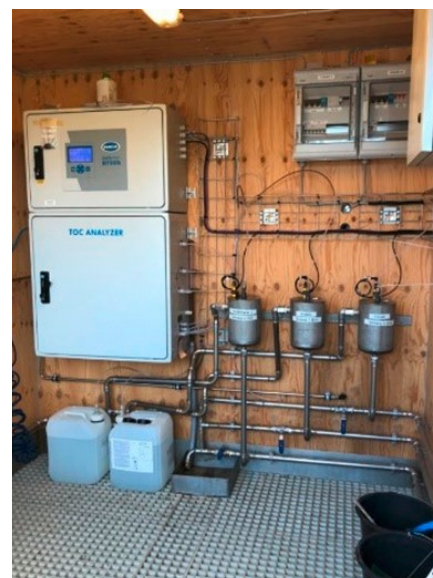
Zdjęcie 1: Analizator Hach BioTector wykonujący pomiar online OWO w ściekach surowych.
