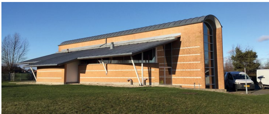
Det vetenskapliga arbetet utfördes på Lundeværket, en del av Vandcenter Syd i Danmark, som är ett typiskt danskt vattenverk.
