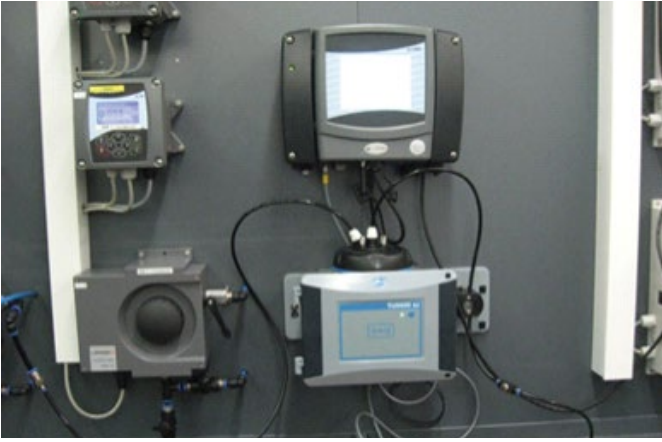
Şekil 3: Bir Alman içme suyu tesisinde SC1000 ile TU5400 kurulumu
