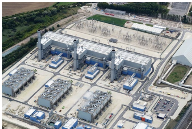
Elektrárna West Burton B CCGT
