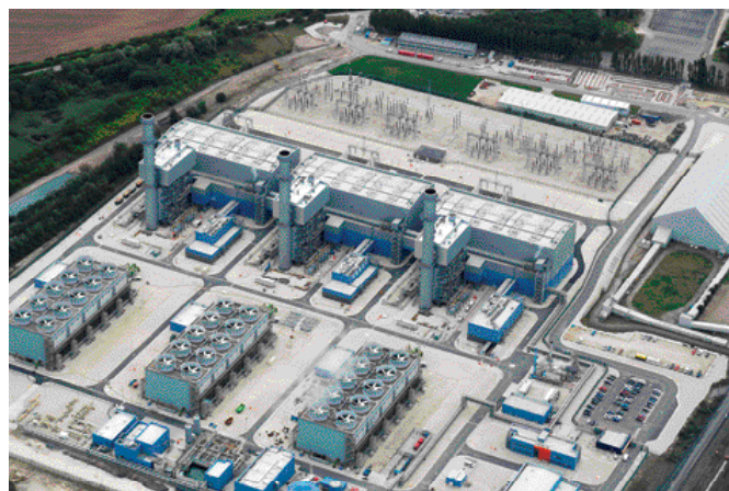
West Burton B CCGT site
