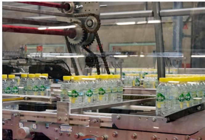
Bottelingslijnen in de installatie
