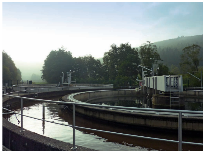
Abb. 1: Kläranlage Medebach / Oberschledorn
