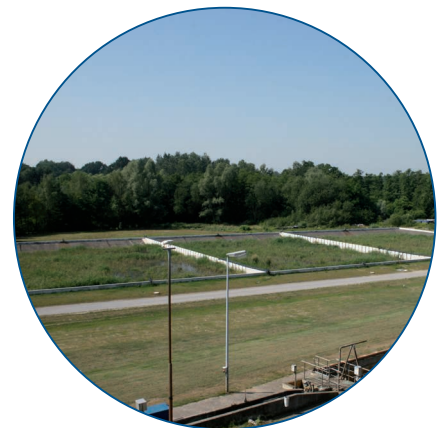
Abb. 5: Blick auf die erste Klärschlamm-Vererdungs-Anlage in NRW
