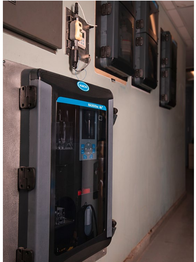
Abb. 2: Der NA5600sc Natrium-Analysator von Hach
