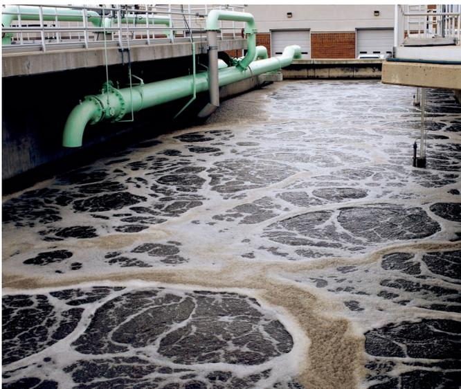
Antes de implantar el controlador en tiempo real, la planta funcionaba en condiciones de aireación fija, que ocasionaban una frecuente sobreaireación, especialmente durante periodos de baja carga, y concentraciones de amonio muy bajas en el efluente. Sin embargo, durante la temporada turística alta, la planta experimentó problemas de cumplimiento, ya que el controlador fijo de OD no respondía ni se adaptaba a las puntas de carga de entrada.
