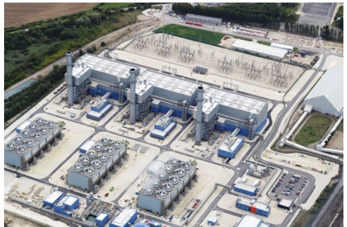
GuD-Standort West Burton B
