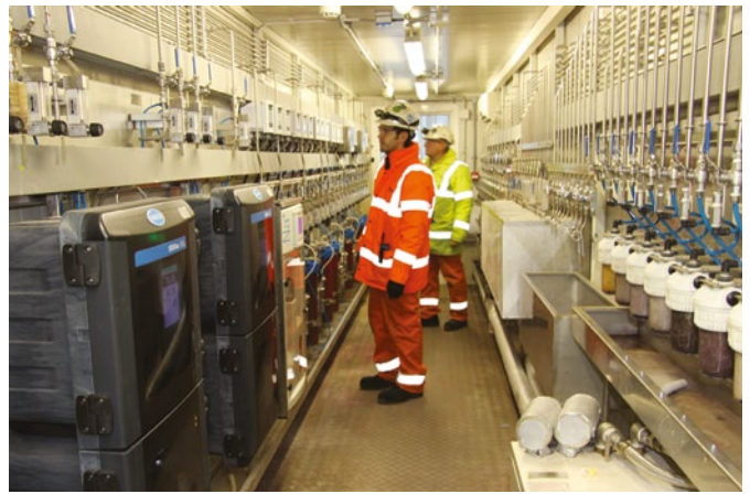
Analysengebäude für die Kessel
