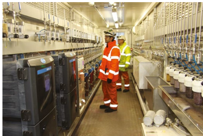
Budynek z analizatorami kotłów
