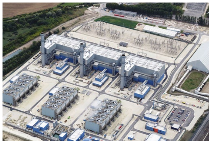
Elektrownia z gazowymi turbinami o złożonej strukturze CCGT w West Burton
