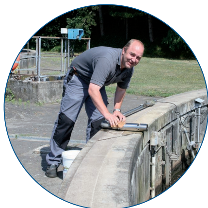
Fig. 2: O director da estação de tratamento Gerold Thiemann tem tudo sob controlo – incluindo a sonda de nitrato NITRATAX plus sc.
