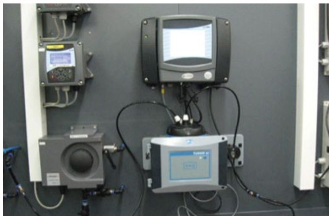
Slika 3: namestitev instrumenta TU5400 z enoto SC1000 v nemški čistilni napravi za pripravo pitne vode
