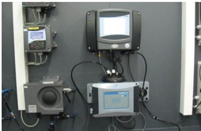
Рисунок 3. Установка TU5400 с контроллером sc1000 на станции водоподготовки в Германии
