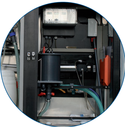
Abb. 1: NITRATAX plus sc Nitratsonde (Bypass), montiert im Probennehmerschrank
