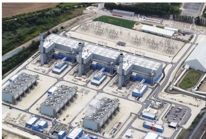
Электростанция West Burton B CCGT
