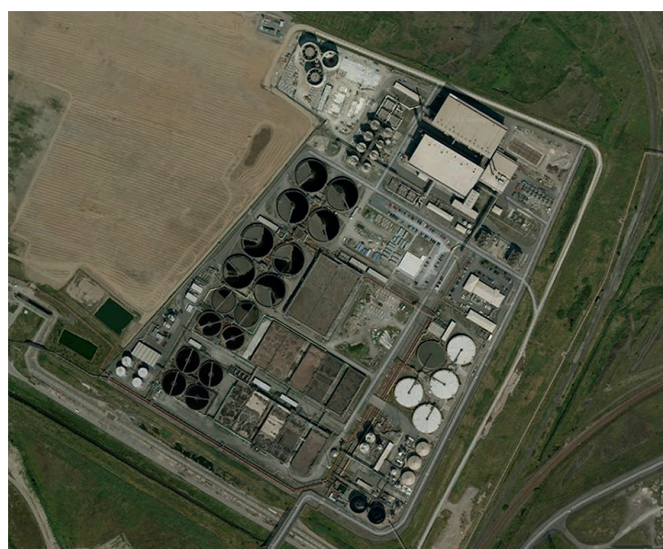
Fig. 1: impianto di trattamento delle acque reflue di Bran Sands
