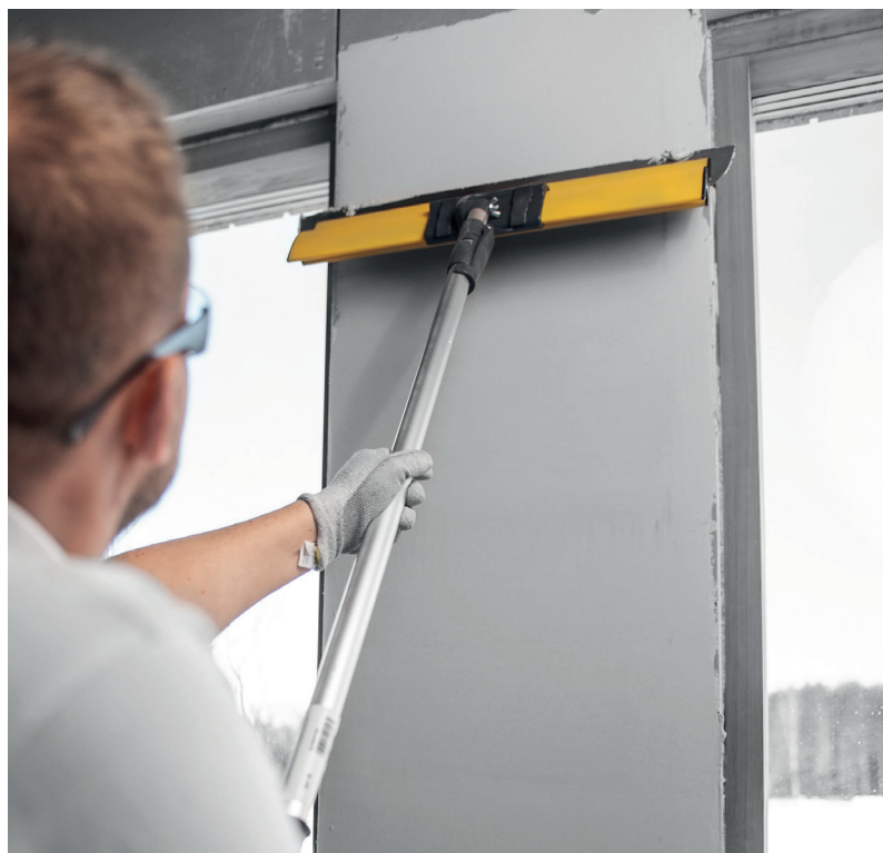
Lissage du plâtre avec une perche d'extension.
