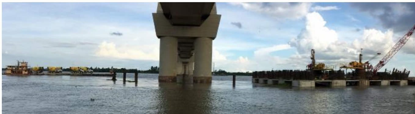
Figura 4. Barcaza que transporta camiones de cemento al Pilote completo. Se requirió un total de 340 m 3 de cemento para completar los 40 Pilotes.
