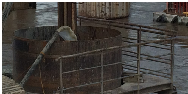
Figura 2. La lechada de POLY-BORE™ se bombea en el pilote para soporte hidrostático
