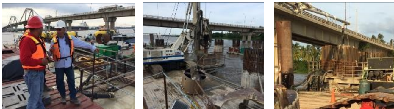
Figura 3. Depósitos de almacenamiento en suspensión POLY-BORE (izquierda), bombeo (medio) de la suspensión POLY-BORE al eje durante la excavación, (derecha) Desplazamiento de POLY-BORE con cemento para completar la pila.
